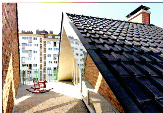
Project Tichel, Gent – architecten de vylder, vinck, tailleu in opdracht van sogent – Foto: Filip Dujardin
